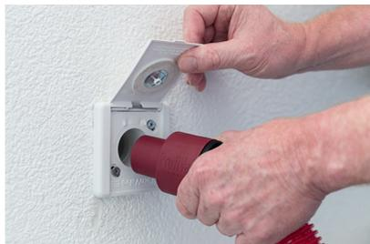
Nach dem Ausschalten des Sauggerätes am Handgriff kann der Anschlussstutzen des Saugschlauches aus der Saugdose entfernt werden.
