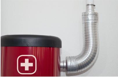
**Abluft** befindet sich rechts vom Gerät.
