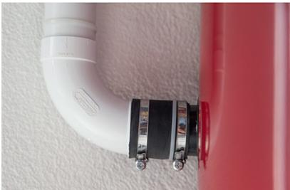
Der Saugstutzen befindet sich links unten am Zentral-Staubsauger. Schieben Sie die Gummimanschette und die anderen beiden
