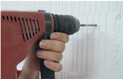
2. Percez les cinq trous avec un foret de 6 mm et suffisamment en profondeur pour que les buses fournies soient complètement enfoncées dans le mur.
