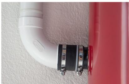
Il bocchettone di aspirazione si trova in basso a sinistra dell'aspirapolvere centralizzato.
