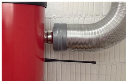
Avvitare a destra dell'apparecchio l'antenna ad asta posta nel serbatoio delle impurità per l'uso WIRELESS.
