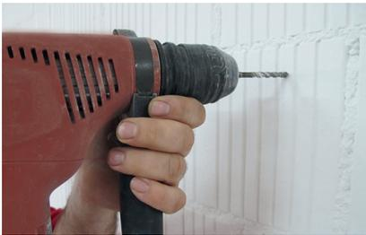
2. Praticare i cinque fori con una punta da roccia di 6 mm ad una profondità tale da poter incassare i tasselli interamente nel muro.
